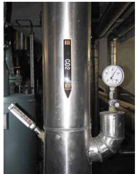
Unter der Tribüne befindet sich der Zugang der Pistenverrohrung. Dies ist auch der einzige Haltepunkt der schwimmend gelagerten Eisfläche. Aggregatzustand des CO 2 -Druck 25 bar, Temperatur -3 °C
