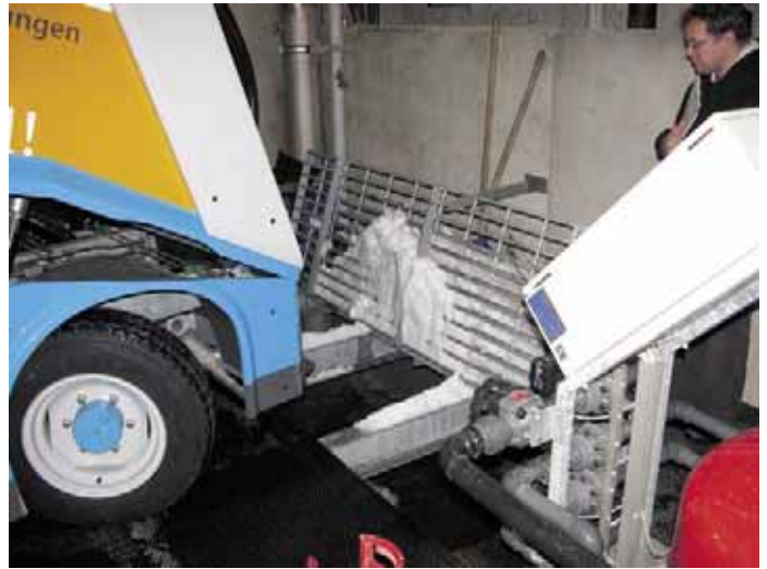
Zwei Beispiele für den energieeffizienten Betrieb des Systems: Für das Brauchwasser wird über einen Enthitzer Wärme aus dem Kältekreislauf entzogen und in einem Puffer zwischengespeichert. Die Schneegrube „entsorgt“ den Eisabrieb und nutzt die Schmelzwärme für den Kühlturbetrieb
