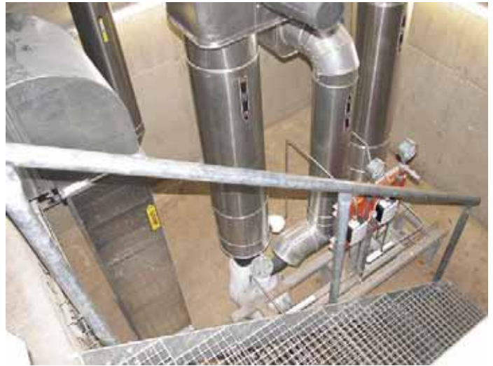
Übereinander angeordnet: Der NH 3 -Abscheider, darunter der Verdampfer bzw. CO 2 -Verflüssiger und schließlich der CO 2 -Abscheider. Über eine Treppe gelangt man zu den CO 2 -Pumpen, die sich nochmals einen Stock tiefer unter dem Verflüssiger befinden, um die erforderliche Zulaufhöhe zu gewährleisten
