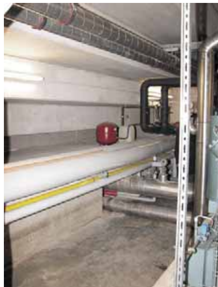
Unter der Tribüne befindet sich der Zugang der Pistenverrohrung. Dies ist auch der einzige Haltepunkt der schwimmend gelagerten Eisfläche. Aggregatzustand des CO 2 -Druck 25 bar, Temperatur -3 °C
