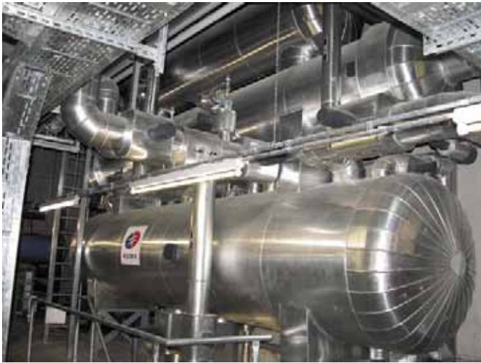
Übereinander angeordnet: Der NH 3 -Abscheider, darunter der Verdampfer bzw. CO 2 -Verflüssiger und schließlich der CO 2 -Abscheider. Über eine Treppe gelangt man zu den CO 2 -Pumpen, die sich nochmals einen Stock tiefer unter dem Verflüssiger befinden, um die erforderliche Zulaufhöhe zu gewährleisten
