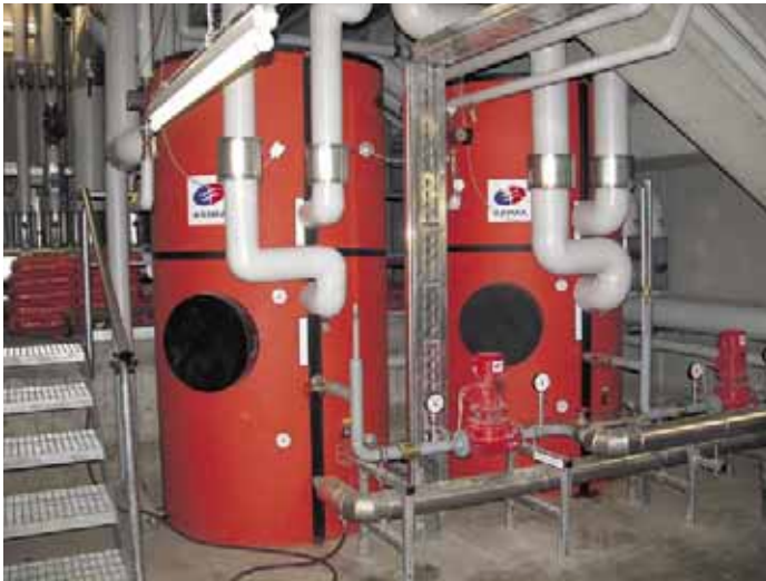
Zwei Beispiele für den energieeffizienten Betrieb des Systems: Für das Brauchwasser wird über einen Enthitzer Wärme aus dem Kältekreislauf entzogen und in einem Puffer zwischengespeichert. Die Schneegrube „entsorgt“ den Eisabrieb und nutzt die Schmelzwärme für den Kühlturbetrieb
