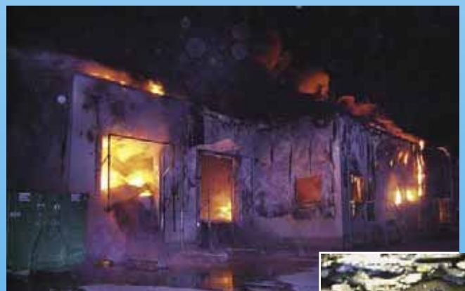
Miet-Kälte verhinderte Schlimmeres
