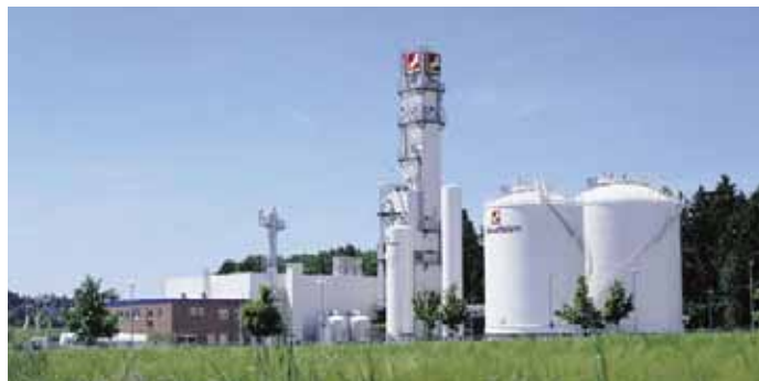
In zwei Luftzerlegungsanlagen – hier im süd-deutschen Laichingen – produziert die Westfalen AG Stickstoff, Sauerstoff und Argon, auch in hochreiner Qualität
