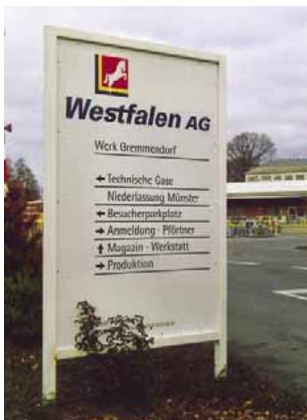
Gremmendorf: Produktion und Abfüllwerk des Geschäftsbereichs Industriegase und Kältemittel
