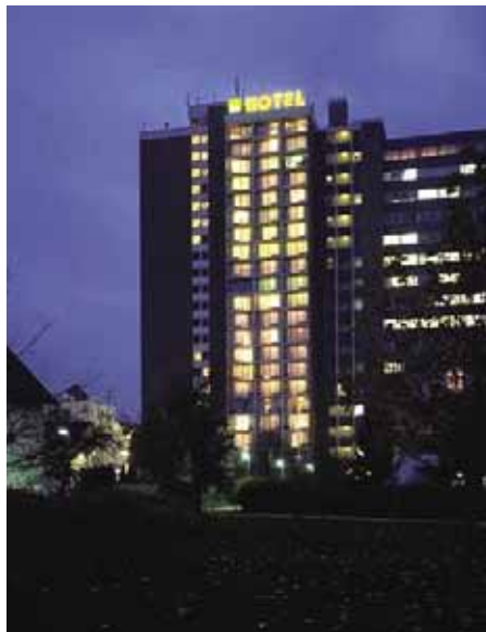
Das Quality Hotel Isabella in Neu-Isenburg wurde mit 35 Innengeräten (Gesamtkälteleistung über 90 kW) und VRF-Technik nachgerüstet
