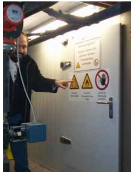
Bild 3 Der besondere Maschinenraum im Maschinenraum
