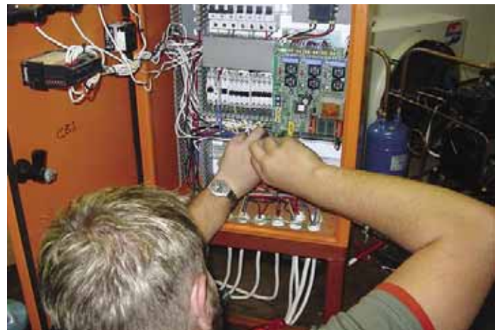
Jacobus Kies montiert einen Softstarter
