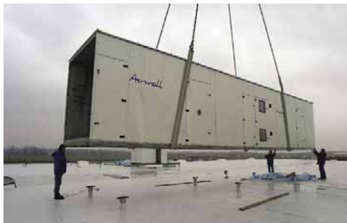
Jeweils 20 Tonnen schwer sind die vorgefertigten IPOC Dachklimazentralen
