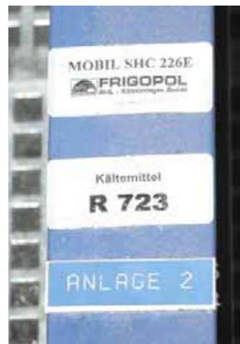
Zwei getrennte Kältekreise sowie der Wille des Betreibers erlauben den vergleichenden Einsatz des etablierten Kältemittels R 404A sowie der neuen Alternative R 723
