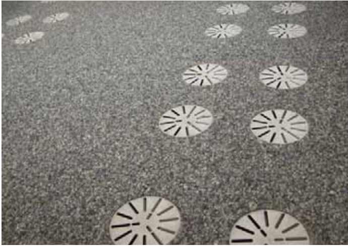
Sowohl für die Schaltwarte, als auch für die Monitorwand wird die Zuluft von unten über Kanäle in einem Doppelboden eingebracht
