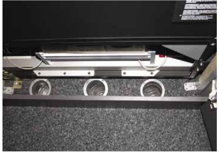
Sowohl für die Schaltwarte, als auch für die Monitorwand wird die Zuluft von unten über Kanäle in einem Doppelboden eingebracht
