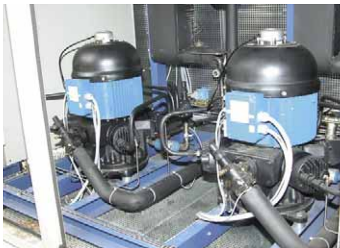
Zwei getrennte Kältekreise sowie der Wille des Betreibers erlauben den vergleichenden Einsatz des etablierten Kältemittels R 404A sowie der neuen Alternative R 723
