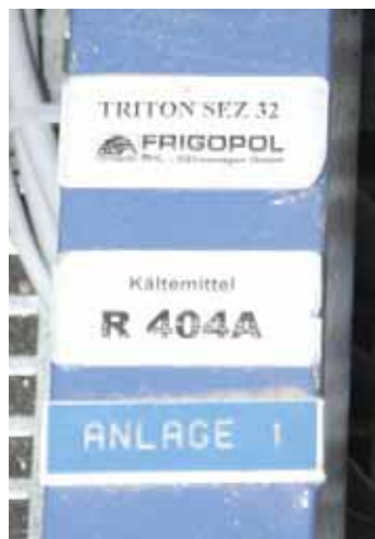
Zwei getrennte Kältekreise sowie der Wille des Betreibers erlauben den vergleichenden Einsatz des etablierten Kältemittels R 404A sowie der neuen Alternative R 723
