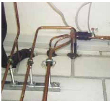
Bild 6 Die Rohrverlegung zeigt die Qualifikation der Monteure, wie auch die Verlegung im Keller mit den Wanddurchgängen
