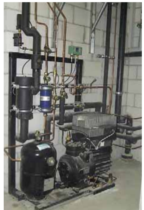
Bild 4 Der Goeldner-Motion Verdichter, Typ HS 223/5,5FU, mit dem aufgeflanschten Lenze-Motec-Frequenzumformer; geliefert als Verdichtersatz mit 7,6l Flüssigkeitssammler
