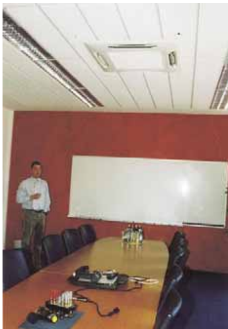
Glückwunsch vom Vater („Herr Klaus“) an Frank, den jüngeren Sohn: Gut gemacht bei der Firma Stäubli: 173 KW VRF-Außeneinheiten vom Fabrikat Kaut/Sanyo mit dem Kältemittel R 410 A, angeschlossen an 55 Deckenkassetten, montiert innerhalb von 4 Wochen während des laufenden Bürobetriebs
