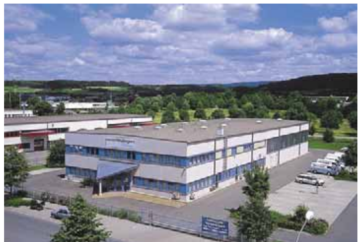
Luftbildaufnahme des Unternehmens heuberger in Bayreuth, 10 000 m 2 umbauter Raum auf 7000 m 2 Grundstücksfläche in der Bindlacher Straße
