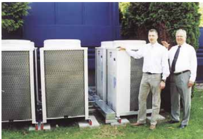
Glückwunsch vom Vater („Herr Klaus“) an Frank, den jüngeren Sohn: Gut gemacht bei der Firma Stäubli: 173 KW VRF-Außeneinheiten vom Fabrikat Kaut/Sanyo mit dem Kältemittel R 410 A, angeschlossen an 55 Deckenkassetten, montiert innerhalb von 4 Wochen während des laufenden Bürobetriebs
