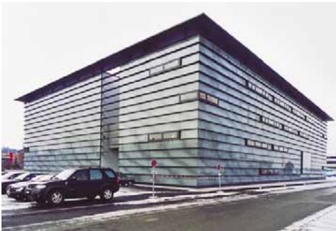
Alles unter Glas: Das neue 70-Millionen-Franken-Testgebäude (65 × 50 × 17 m hoch) mit modernster Windkanal-Technologie von Sauber Petronas, am 16.12.2003 in Hinwil (Schweiz) offiziell in Betrieb genommen (Alle Werkbilder Axima Refrigeration GmbH)
