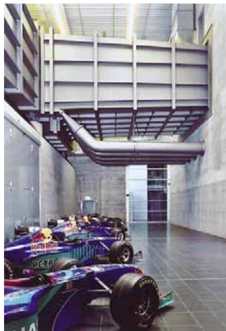
Industriegebäude, Windkanalhalle, aber auch Formel-1-Museum und bei Bedarf Eventbereich als Marketinginstrument, so gliedert sich das 70-Millionen-Franken-Testgebäude von Sauber Petronas in mehrere Transparentbereiche
