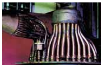
Bündelrohrverdampfer eines DK-Kaltwasserbereiters
