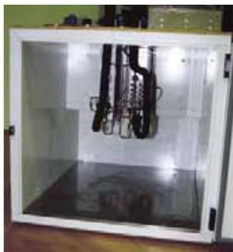
Zwei Verdampfer in einem Kühlraum – symbolisiert durch ein für den BLW gesponsertes Kühlkabinett von ILKAZELL –, die wechselseitig und zeitgleich kühlen und abtauen
