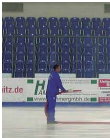
Bild 4 Der Wasserfilm für die erste Eisschicht wird gleichmäßig aufgetragen
