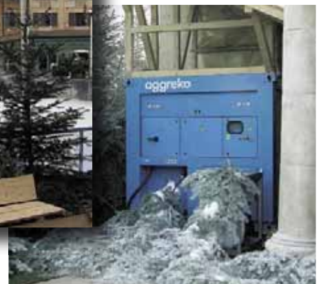
Eislaufen in italienischem Ambiente. Das für die Eisbahn benötigte Kälteaggregat von aggremo wurde unauffällig hinter dem Collosseum platziert
