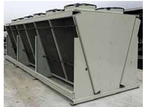
Bild 6 CO 2 -Gaskühler auf dem Dach des Megastores
