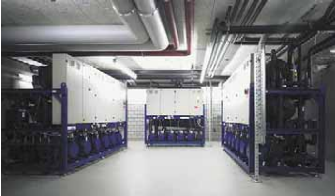
Bild 3 Maschinensätze für Normal- und Tiefkühlung
