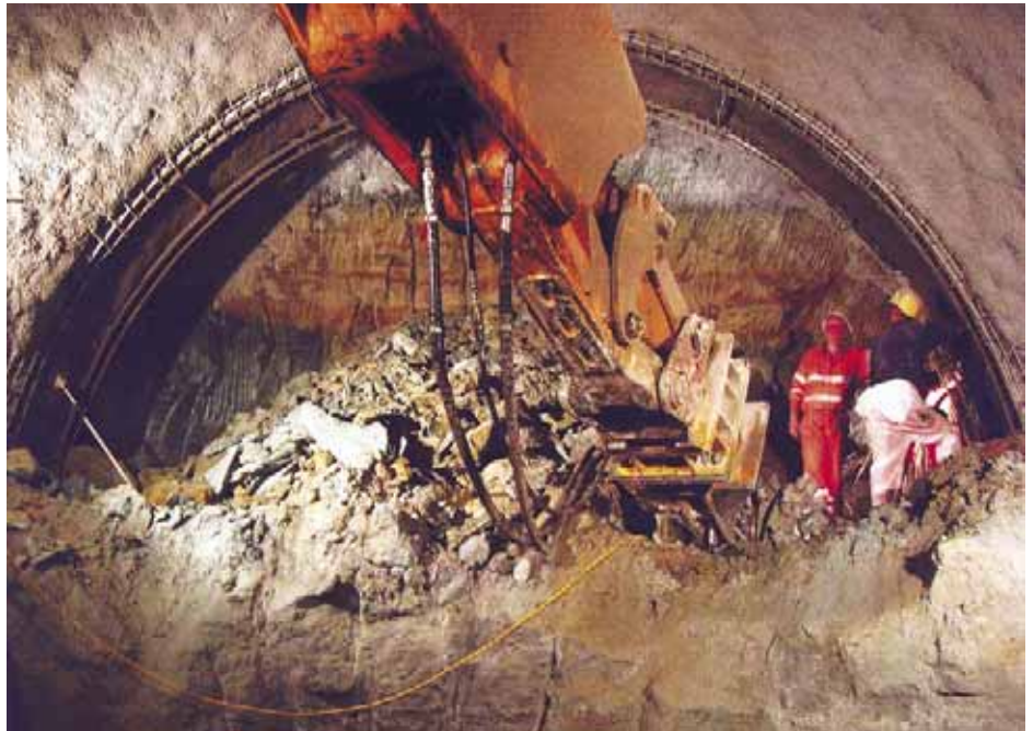
Profilieren des gefrorenen Bodens im Kalottenbereich
