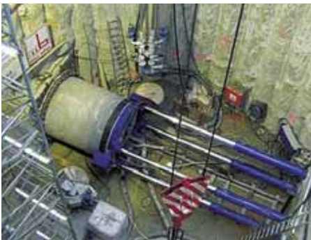
Vorpressen der Stahlbetonrohre
