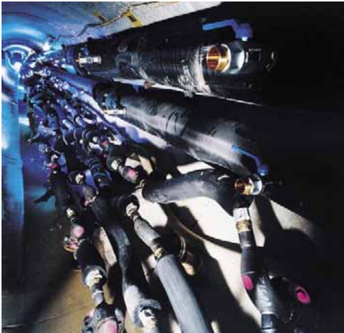
Rohrleitungen und Gefrierköpfe im Pilotstollen: Vor und während der Vereisung
