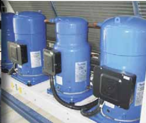
Zwei Kälteerzeuger auf Glykolbasis mit Scrollverdichtern sorgen für eine bedarfsgerechte Kühlung
