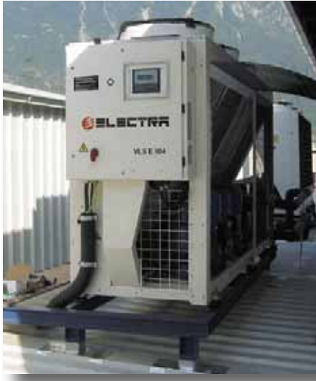
Zwei Kälteerzeuger auf Glykolbasis mit Scrollverdichtern sorgen für eine bedarfsgerechte Kühlung
