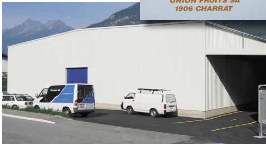
Modernes Kühllager in der Schweiz
