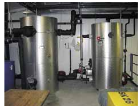
Plattenwärmeübertrager für die Solekühlung. In dem einen Speicher befindet sich die Sole. Der andere speichert die zurückgewonnene Enthitzungswärme für die Kühlraumverdampfer
