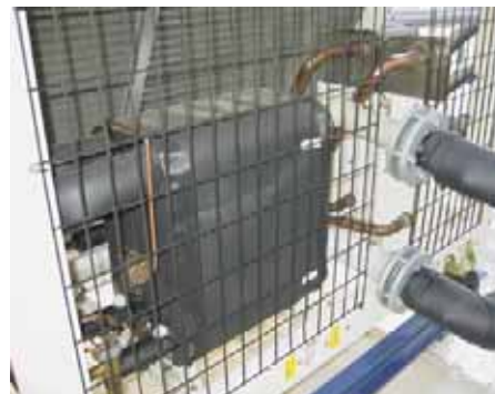
Plattenwärmeübertrager für die Solekühlung. In dem einen Speicher befindet sich die Sole. Der andere speichert die zurückgewonnene Enthitzungswärme für die Kühlraumverdampfer
