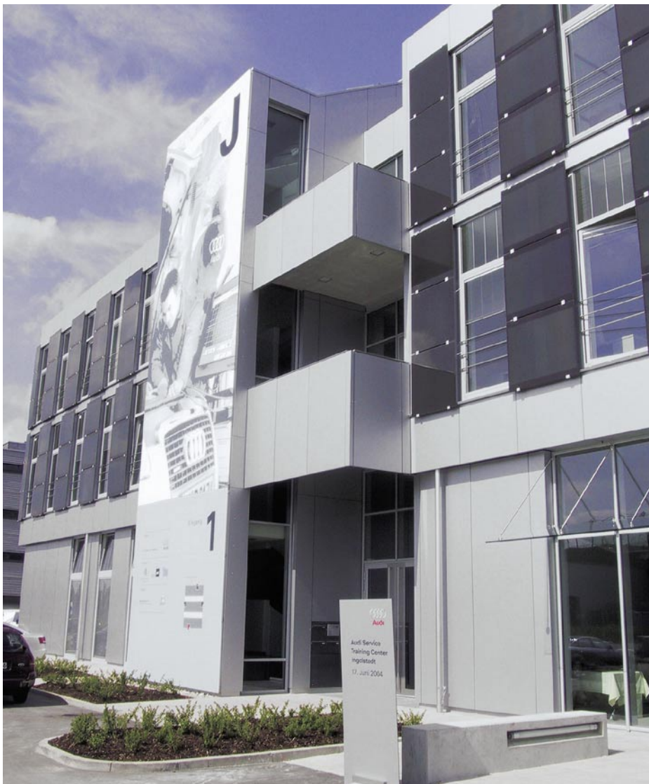
Eingangsbereich der Halle J des Ingolstädter Güterverkehrszentrums. Die fassadenintegrierte Photovoltaikanlage mit 18 kW p passt sich optimal in das Gebäude ein
