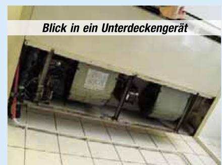
Drei Beispiele für die mangelhafte Wartung von Klima- und Lüftungsanlagen
