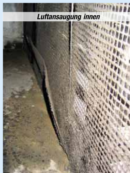
Drei Beispiele für die mangelhafte Wartung von Klima- und Lüftungsanlagen
