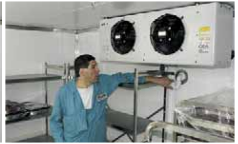
Josef Köppel, bauleitender Monteur des Kälte- und Großküchenfachbetriebs Muhr GmbH, Viechtach, erläutert Michael Münch von der Küba Kältetechnik Details der unüblichen Kunststoffabhängung der Verdampfer und der besonderen Problematik bei der Tauwasserabführung
