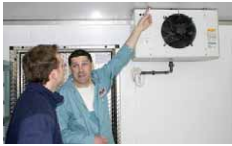
Josef Köppel, bauleitender Monteur des Kälte- und Großküchenfachbetriebs Muhr GmbH, Viechtach, erläutert Michael Münch von der Küba Kältetechnik Details der unüblichen Kunststoffabhängung der Verdampfer und der besonderen Problematik bei der Tauwasserabführung
