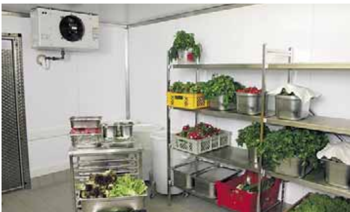
Temperaturwechsel: Auf dem linken Bild wird Gemüse mit kleiner Temperaturdifferenz und großer Verdampferfläche „offen“ gekühlt, auf dem rechten Bild ist das Gefriergut im Tiefkühlraum natürlich „verpackt“!
