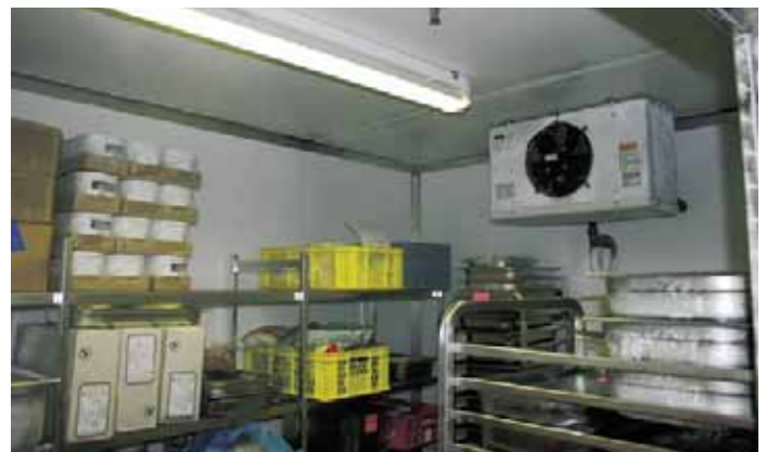
Temperaturwechsel: Auf dem linken Bild wird Gemüse mit kleiner Temperaturdifferenz und großer Verdampferfläche „offen“ gekühlt, auf dem rechten Bild ist das Gefriergut im Tiefkühlraum natürlich „verpackt“!
