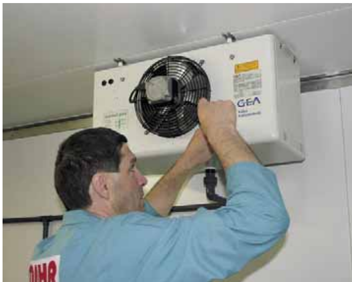
Obermonteur Josef Klöppel bei der Endmontage eines SP-Verdampfers
