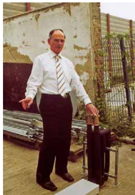
Erdwärmesonden mit Sole als Wärmeträgerflüssigkeit, hier mit 100 m Länge (Tiefe) auf dem Betriebsgelände der Firma KAELETRO für Vergleichsmessungen installiert, sind in der Wassergefährdungsklasse 1 eingestuft und benötigen zusätzliche Pumpenenergie
