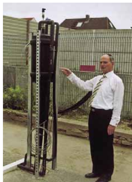
Von der Rolle: Flexibles Edelstahlrohr, hier Kälteanlagenbauermeister Christian Scholz mit einem Rhönradauglichen Resteverschnitt, dient in einer Länge von 100 m als Erdwärmerohr dem CO 2 als Transportfluid; auf dem rechten Bild fertig installiert mit isoliertem Wärmeaustauscher und AKV
