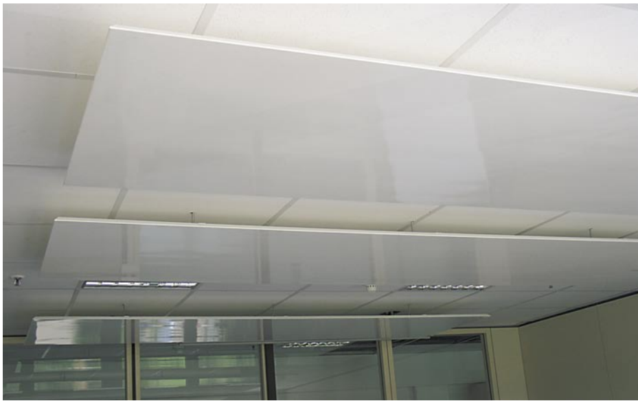
Bild 4 Raum mit Deckensegeln
