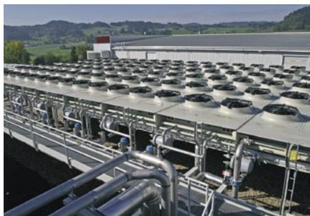
So weit das Auge reicht: 144 Axialventilatoren sorgen für eine energetisch günstige Kältemittelverflüssigung und Sole-Rückkühlung auf dem Dach des Galliker Logistikgebäudes
