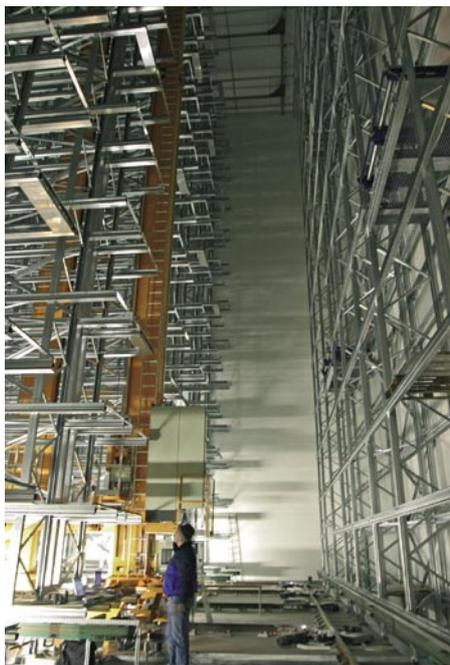
*Ein Eindruck aus dem automatischen Tiefkühl-Hochregallager während der Montage; Innenraumhöhe 28 m!*
