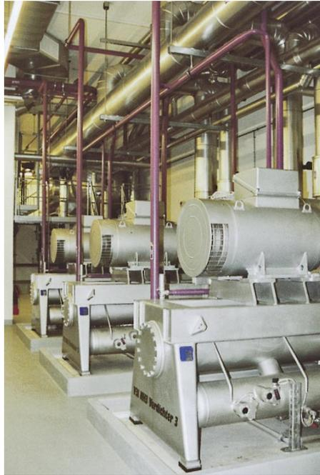
Eindrücke aus dem Maschinenraum mit 3 Schraubenverdichtern (Kälteleistung ca. 1200 kW – 37°C/+25°C) für den Tiefkühlbereich und 2 Kolbenverdichtern für die Wärmepumpe (Heizleistung ca. 1500 kW +25°C/+67°C); alles säuberlich und jedes Komponententeil zusätzlich perfekt gekennzeichnet
