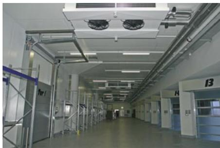
*An- und Auslieferungsdistribution mit seitlichen Andockkrampen, auf +5 °C durch Deckenflachluftkühler des Fabrikats Güntner mit einem Kälte-träger gekühlt*
