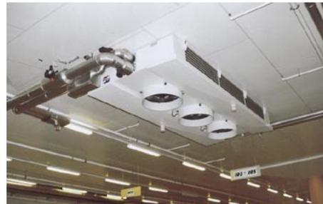
*Auslieferungs-Bereitstellungsebene +5 °C mit Sole-Deckenflachluftkühlern, jeweils 80 kW Kühlleistung; saubere Verrohrung hier an einem Beispiel*
