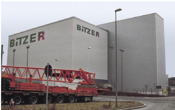
Bitzer Kühlmaschinen GmbH Schkeuditz; 13 000 m 2 Produktionsfläche auf einem Gesamtareal von 27 613 m 2 . Hier eine Außenansicht mit den Hochregallagern
