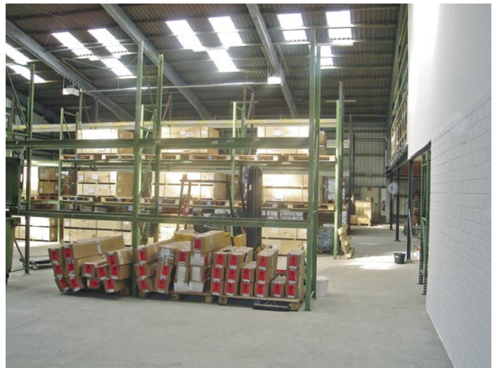
Die neue Lagerhalle der Raffel-Searle GmbH Kältetechnik in Wachtberg bei Bonn
