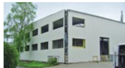
Mit der neuen Lagerhalle in Wuppertal erhöht Kaut die Lagerkapazität um fast 40%
