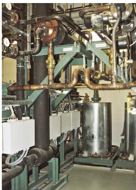
Aus dem Maschinenraum: 6 Verbundsätze der compact Kältetechnik Dresden mit insgesamt 32 Bitzer-Schraubenverdichtern sind dort aufgestellt. Das linke Bild zeigt Ölabscheider und Rohrkondensatoren für die Wärmerückgewinnung
