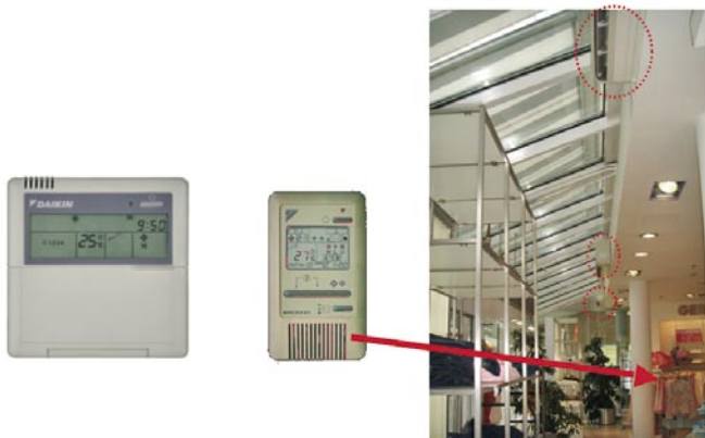
Der Luftansaugfühler misst (oft) nicht die reale Raumtemperatur! In solchen Fällen ist es möglich, den Fühlerort in die Fernbedienung zu verlagern oder einen Fernfühler zu verwenden
