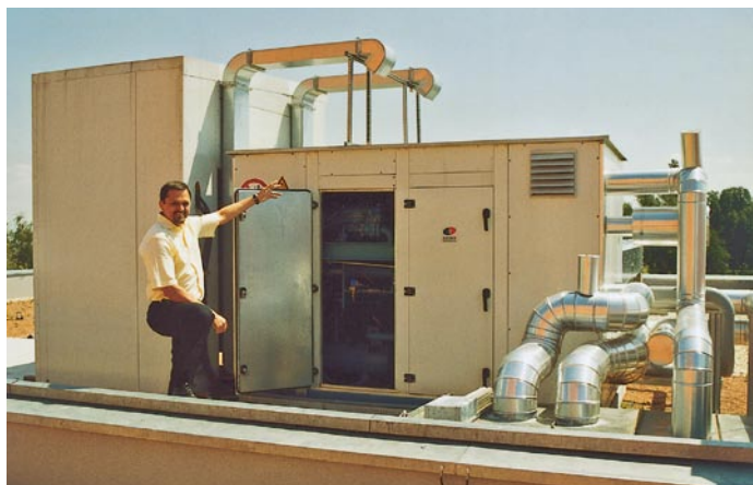
Solekühlsatz und Rückkühler in einer Dachdraufsicht; Teilansicht der Maschineneinhausung aus doppelschaligem Schallschutzpaneel. Darin zwei halbhermetische Schraubenverdichter des Fabrikats Bitzer mit dem Kältemittel R1270, Kaltsole wird über einen Trockenexpansionsverdampfer auf -24^{\circ}\text{C} gekühlt. Die Maschineneinhausung wird über zwei explosionsgeschützte Ventilatoren entlüftet. Planung von Eur-Ing. Christian Holzinger (Wien), Ausführung durch Axima Kältetechnik (Lauterach)
