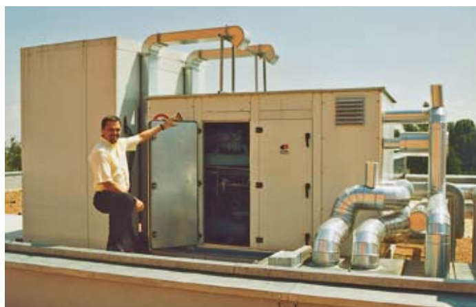
Solekühlsatz und Rückkühler in einer Dachdraufsicht; Teilansicht der Maschineneinhausung aus doppelschaligem Schallschutzpaneel. Darin zwei halbhermetische Schraubenverdichter des Fabrikats Bitzer mit dem Kältemittel R1270, Kältssole wird über einen Trockenexpansionsverdampfer auf -24^{\circ}\text{C} gekühlt. Die Maschineneinhausung wird über zwei explosionsgeschützte Ventilatoren entlüftet. Planung von Eur-Ing. Christian Holzinger (Wien), Ausführung durch Axima Kältetechnik (Lauterach)
