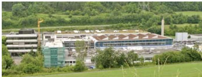
Das neue Großraumbüro (rechts), das eine Fläche von rund 2000 m<sup>2</sup> einnimmt, entstand ganz bewusst nicht als Neubau irgendwo auf der grünen Wiese, sondern wurde direkt auf das Dach von bestehenden Produktionshallen aufgesetzt
