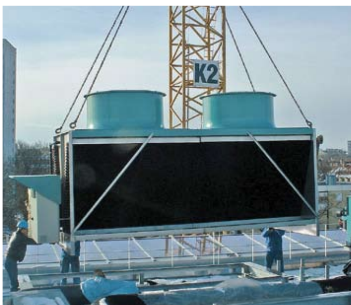
Jäggi-Güntner-Hybride Trockenkühler. Hohe Leistung, kostensparend, umweltverträgliches Kühlverfahren
