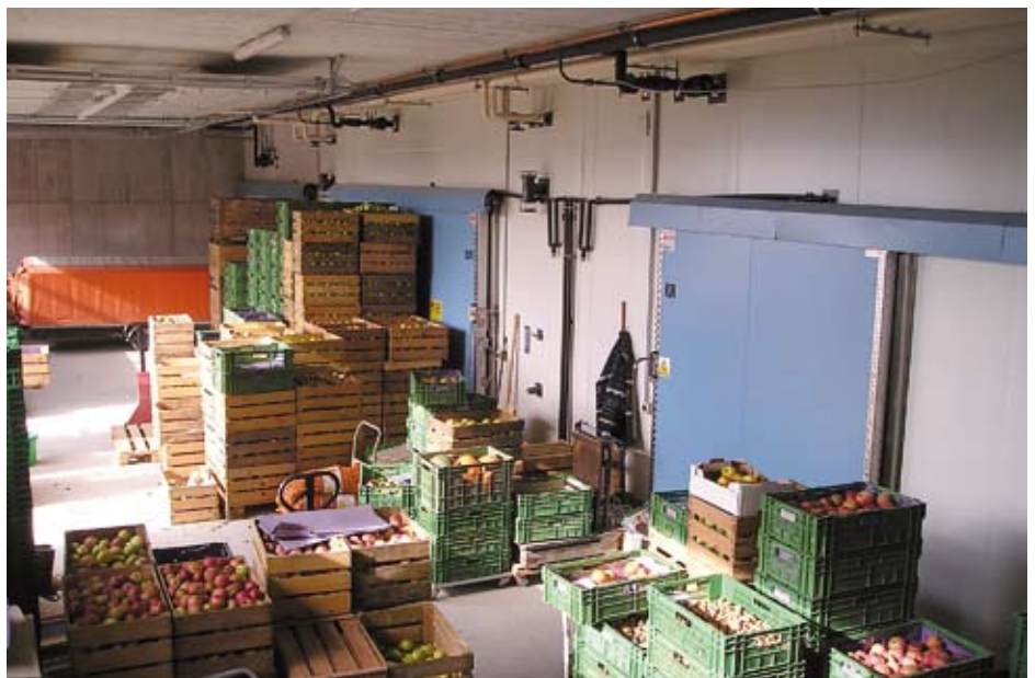
Apfellagerung in 3 Kühlräumen (nicht begehbar) bei kontrollierter CO 2 - und O 2 -Atmosphäre
