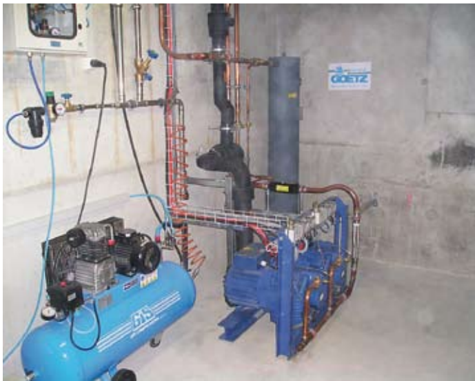
Im Maschinenraum sind einerseits die 2 Bock-Verdichter und ein Druckluftherzeuger für pneumatische Regelungsaufgaben, andererseits der Stickstoffgenerator sowie dahinter der CO 2 -Abscheider platziert
