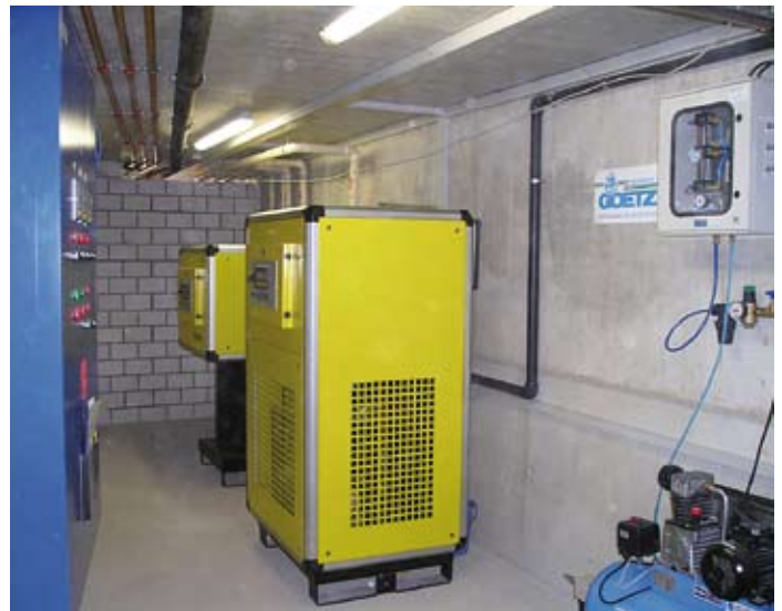
Im Maschinenraum sind einerseits die 2 Bock-Verdichter und ein Druckluftherzeuger für pneumatische Regelungsaufgaben, andererseits der Stickstoffgenerator sowie dahinter der CO 2 -Abscheider platziert
