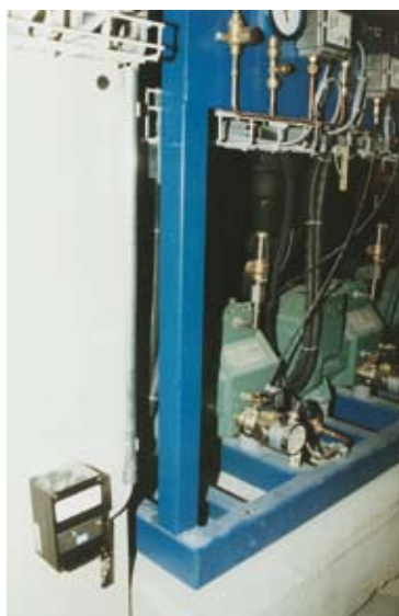
Daniel Baumann vor der Verbundanlage CO 2 -Kaskaden-Tiefkühlung (gefertigt von friosol) mit 4 Bitzer-Verdichtern im Maschinenraum von Coop Interlagen Ost
