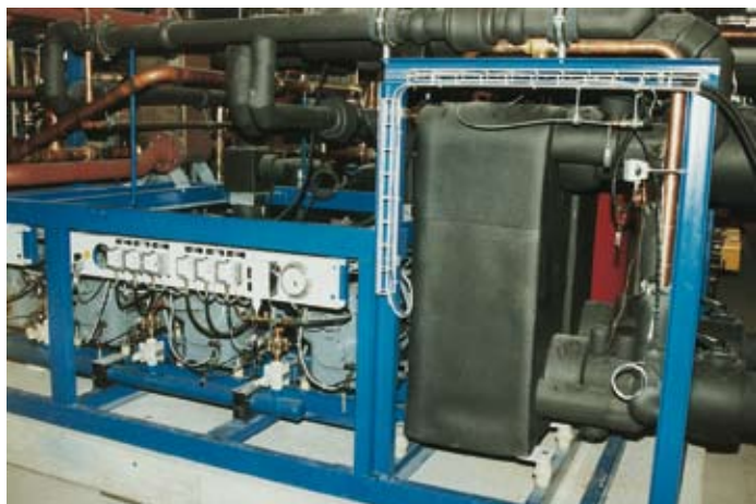
Platten-Wärmetauscher für den Pluskühlbereich, aber auch für die Kondensatorleistung der CO 2 -Kaskaden-Tiefkühlanlage
