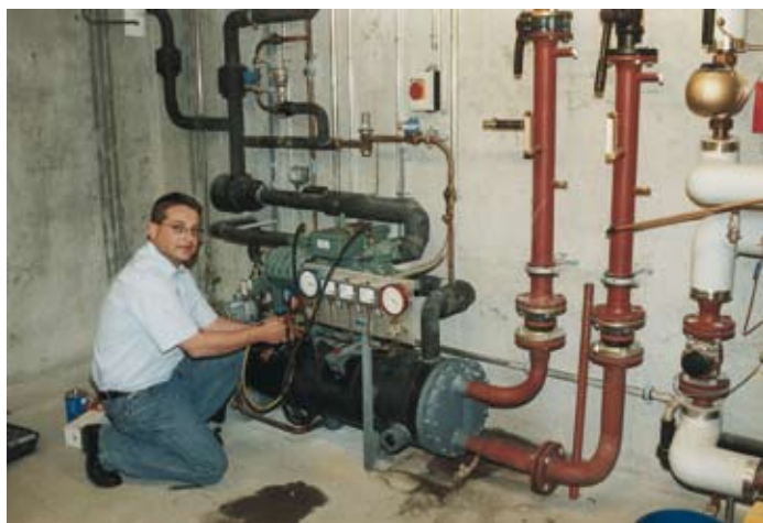
Daniel Baumann vor der Verbundanlage CO 2 -Kaskaden-Tiefkühlung (gefertigt von friosol) mit 4 Bitzer-Verdichtern im Maschinenraum von Coop Interlagen Ost
