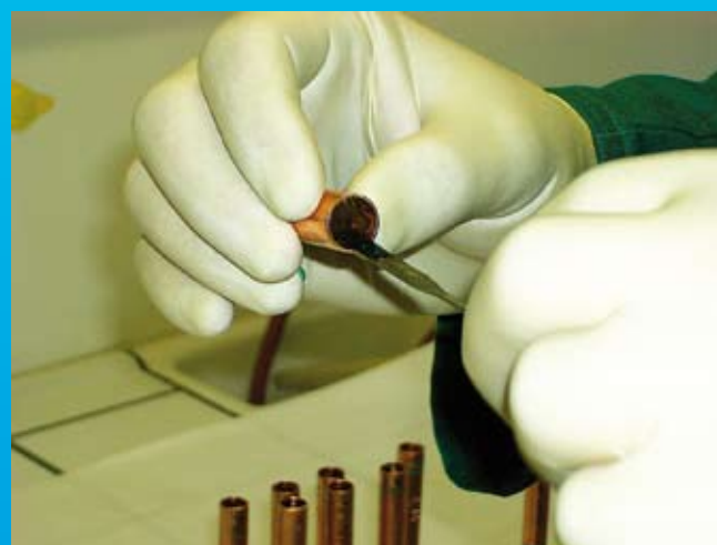
Klebeverbindungen in der Kältetechnik, Teil 1
