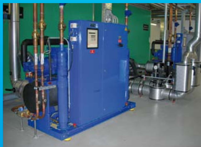
Sanierung von Wasserkühlanlagen
