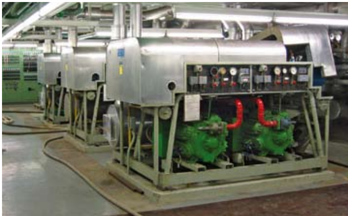
Eiswasserkühlanlage vor der Sanierung, Totalkälteleistung 3-mal 300 kW, Kältemittel R22
