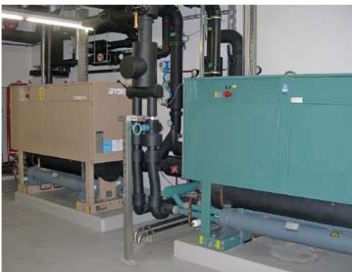
Solekühlanlagen mit Kältemittel R134a
