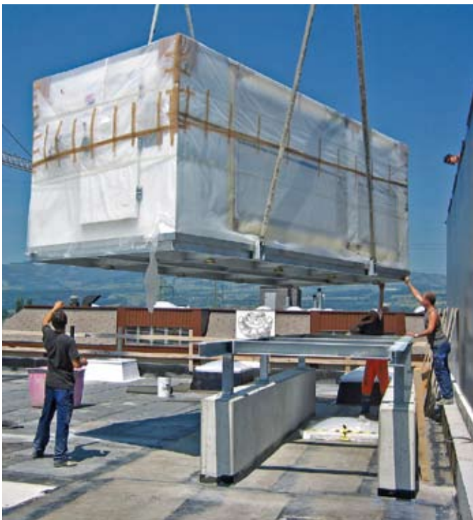
... Positionieren auf Trägerfundamenten an der Tiefkühlager-Außenwand
