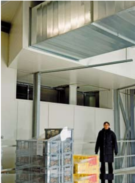
Luftansaug- und Kanalanschluss der Isolierkühler
