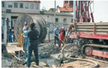
Erdwärmesonden-Bohrungen beim FKW in Hannover
