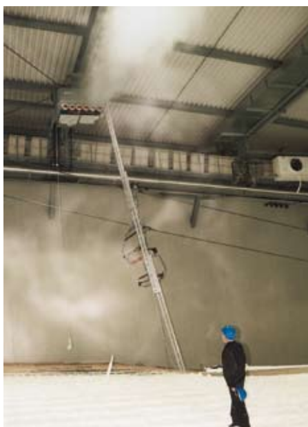
Noch in der Erprobungsphase: 13 neuartige INNOVAG-Schneekanonen produzieren aus einem Wasser-Druckluftgemisch (2m 3 /h) Pulverschnee, der auch am Boden nicht zusammensackt. Um in 14m Höhe arbeiten zu können, ist Bergsteigerqualifikation bei den Monteuren Voraussetzung
