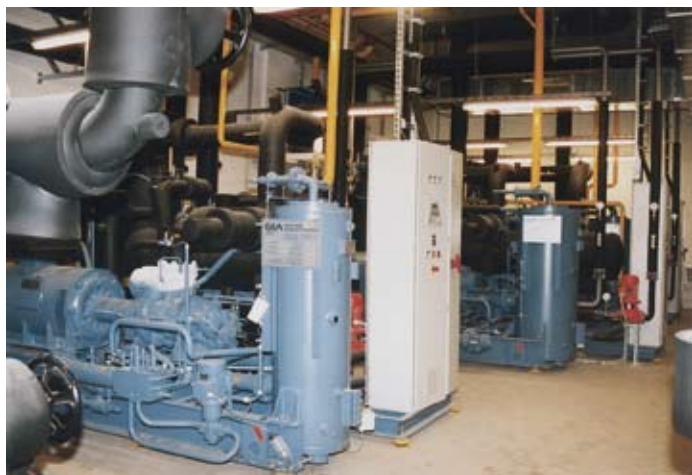
Teilansichten des Maschinenraums mit 3 Grasso-Chillern, Solebehälter und Pumpenstationen
