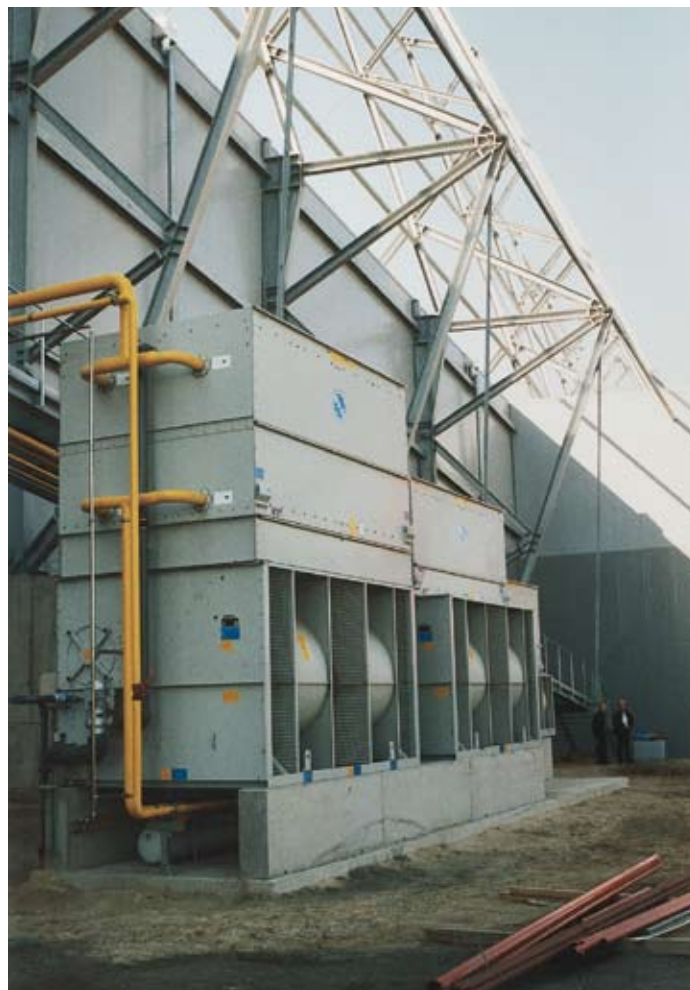
Das Außenskelett des SNOW DOME Bisingen mal aus einer anderen Perspektive gesehen, dahinter ist die Isolierhülle der Skihalle sichtbar. Davor 3 Verdunstungskühler von Baltimore Air-Cool mit einer Gesamtleistung von 3397 kW
