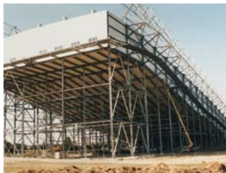
Damit Ski- und Snowboardfahren wirklich funktioniert, ist die Hallenkonstruktion für Start und Ziel schräg angeordnet. Das Pistengefälle beträgt 25 %
