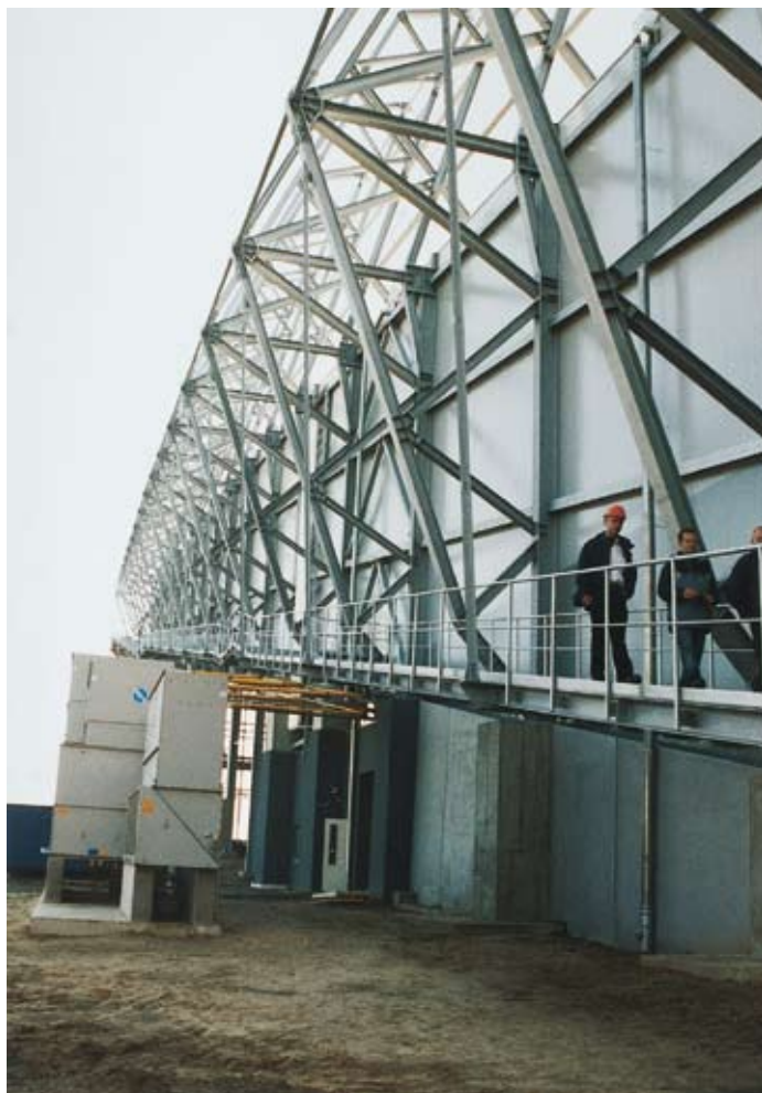
Das Außenskelett des SNOW DOME Bisingen mal aus einer anderen Perspektive gesehen, dahinter ist die Isolierhülle der Skihalle sichtbar. Davor 3 Verdunstungskühler von Baltimore Air-Cool mit einer Gesamtleistung von 3397 kW
