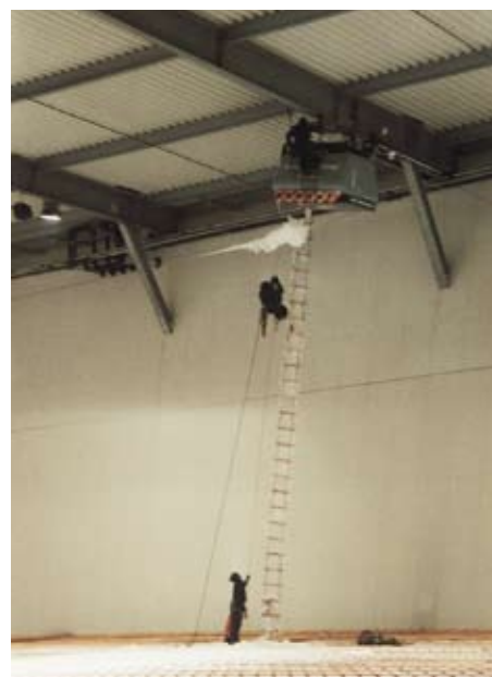
Noch in der Erprobungsphase: 13 neuartige INNOVAG-Schneekanonen produzieren aus einem Wasser-Druckluftgemisch (2m 3 /h) Pulverschnee, der auch am Boden nicht zusammensackt. Um in 14m Höhe arbeiten zu können, ist Bergsteigerqualifikation bei den Monteuren Voraussetzung
