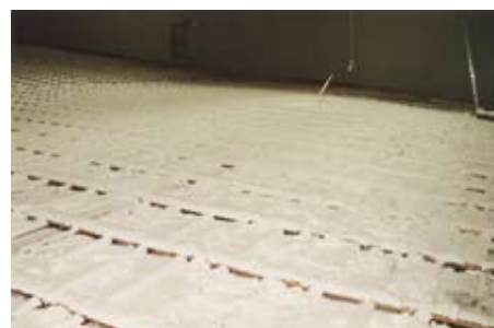
Innenansichten bei -3°C; die Piste ist 280 m lang. Der Beschneievorgang läuft, bis eine Schneehöhe von ca. 30 m erreicht ist. Damit im Sommer trotz der guten Hallenisolierung der Schnee nicht schmelzen kann, gibt es eine Bodenkühlung für mehr als die Hälfte der Halle: 50 km Kunststoffschläuche, 20 mm ø, führen Kaltsole von -5°C mäanderförmig entlang zwischen den hier sichtbaren Stegen
