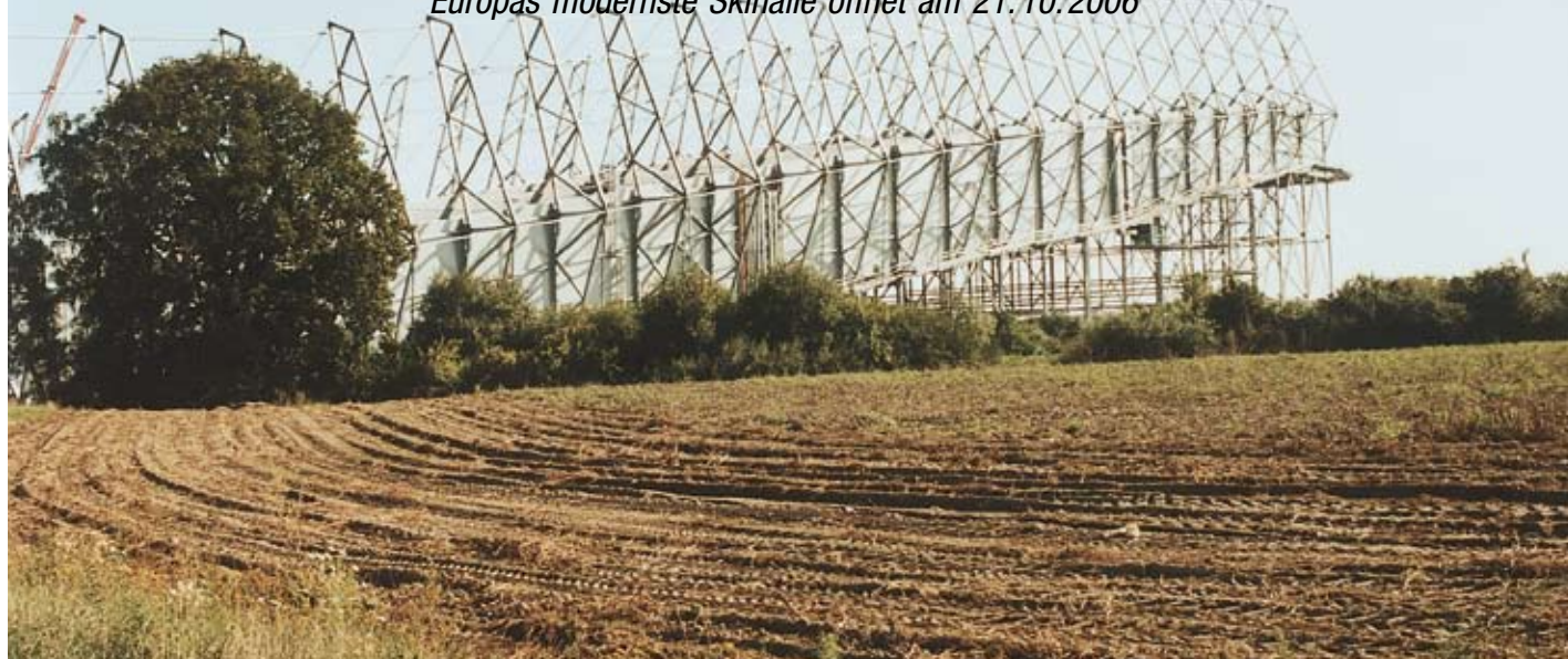
Aus der Ferne gesehen das in die Landschaft eingebettete Außenskelett des neuen SNOW DOME in Bispingen, mit seinen rippenartigen Stahlstreben
