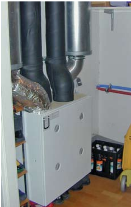
Um den erhöhten schalltechnischen Anforderungen gerecht zu werden, kommen immer häufiger Schalldämpfer zum Einsatz
