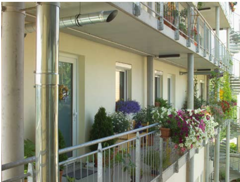
Bei der Positionierung der Außenluftansaugung müssen insbesondere in Mehrfamilienhäusern die am Gebäude auftretenden Strömungsverhältnisse berücksichtigt werden
