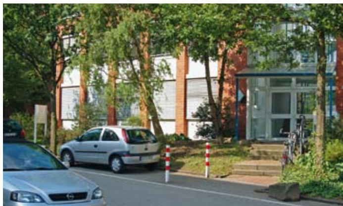
Die Ciat Kälte- und Klimatechnik hat ihren Hauptsitz von Hamburg nach Dortmund verlegt. Im ersten Halbjahr konnte das Unternehmen die ohnehin ambitionierten Ziele weit übertreffen
