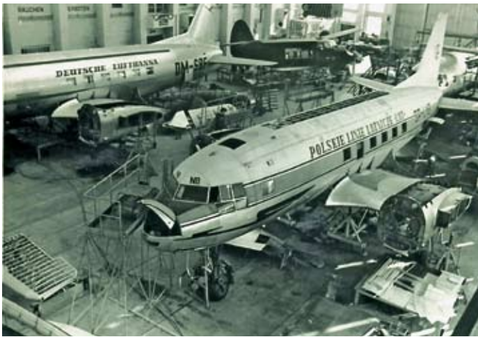
MAB als zentrale Reparaturwerkstatt des RGW, Generalüberholung von Flugzeugen IL 14
