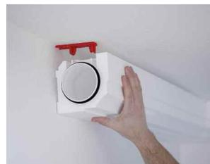
Reale Montagesituationen bieten das ideale Umfeld, um beispielsweise die komplette Verlegung des RenoPipe Luftverteilsystems für die energetische Sanierung durchzuführen.
